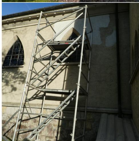
Les murs étaient fissurés à l'extérieur (problème d'Étanchéité). Il fallait traiter ce problème d'abord avant de peindre l'intérieur de la chapelle.
