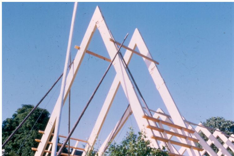
Août 1969 : la chapelle en construction.
